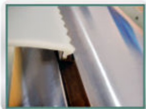
由中间向两端安装
